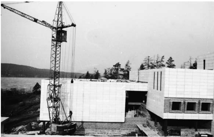
Строительство современного здания музея Ильменского государственного заповедника. 1982 г.
