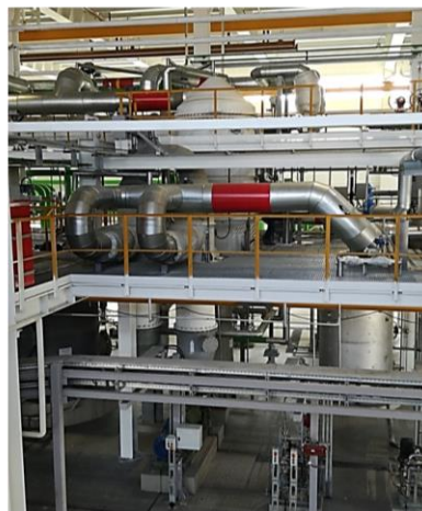
Рис. 67. Переработка регенерационных стоков на Челябинской ГРЭС.
