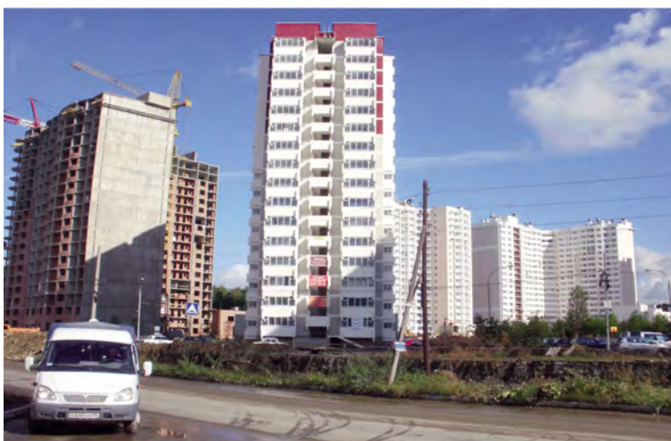
Строительство по инвестиционным договорам УрО РАН, сентябрь 2011 г.
