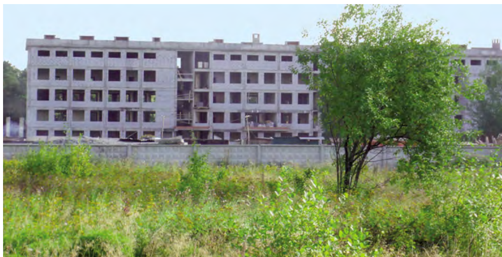
Строящееся здание ИГГ, сентябрь 2011 г.
