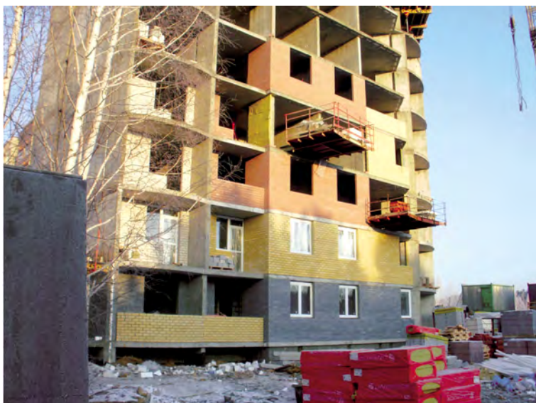
Строительство жилого дома по инвестиционному договору с ЗАО «Корпорация «Атомстройкомплекс»»
